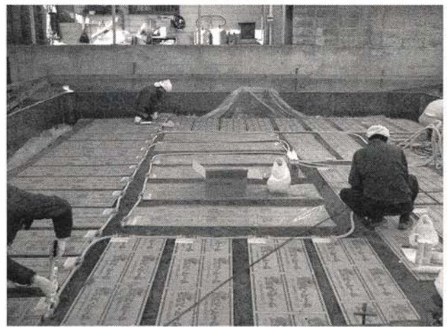
「サーマ・スラブ」の施工風景
