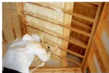
断熱材「フォームライトSL」吹き付けの様子
