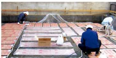
「サーマ・スラブ」の施工風景
